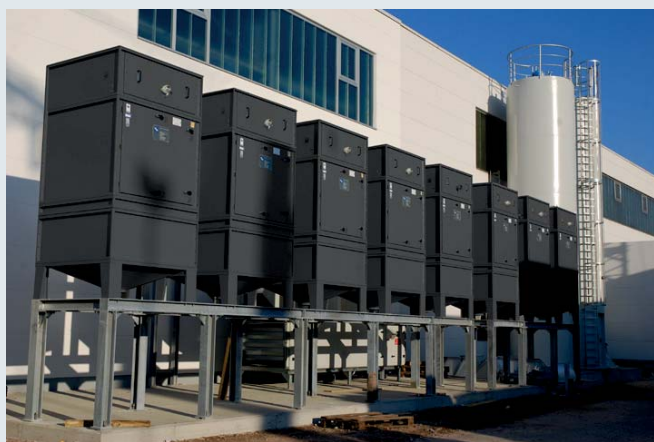
ZPF modulaires connectés en série avec une capacité d'aspiration et une surface filtrante accrues
