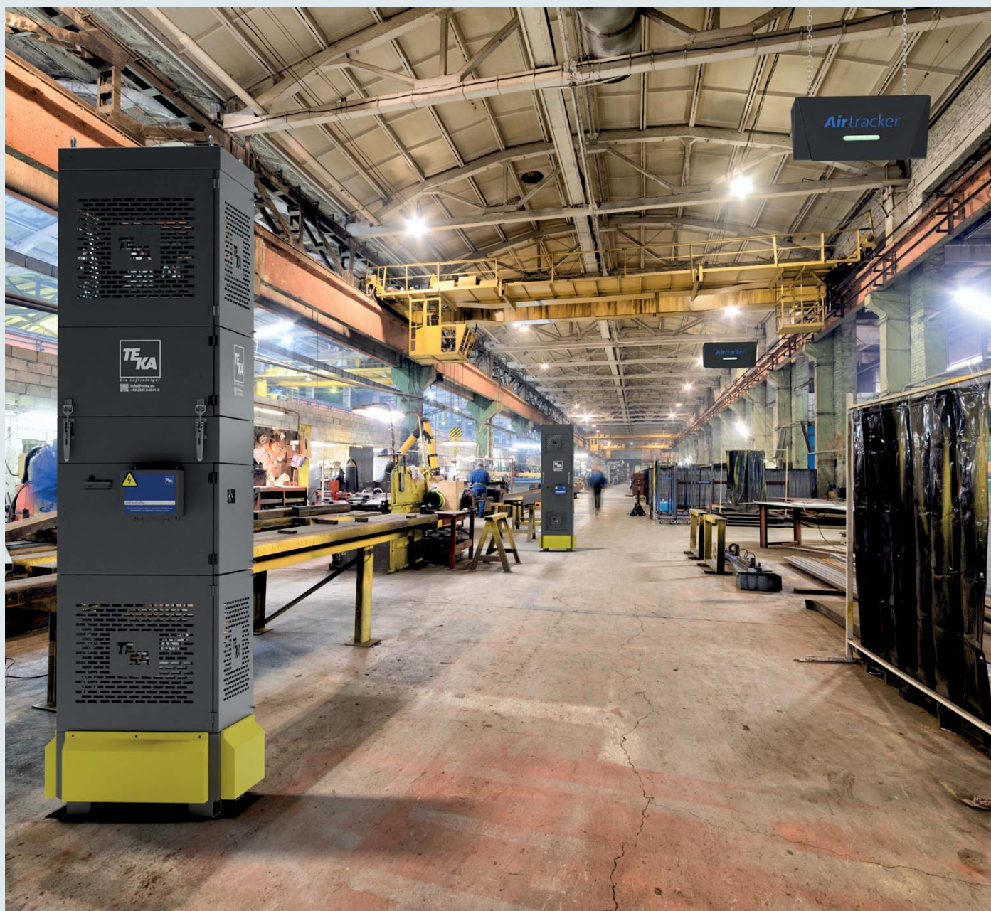
Exemple d'application CleanAirCubes avec Airtrackers
